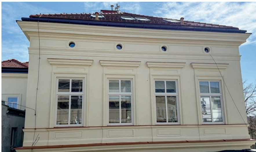
Opravená fasáda školy
