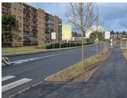
Opravy chodníků a vozovky v ul. Rukavičkářská a Nad Papežem
