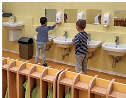
Rekonstrukce sociálního zařízení v 5. MŠ
