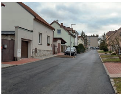
Oprava povrchů vozovky i chodníku v ul. Nová
