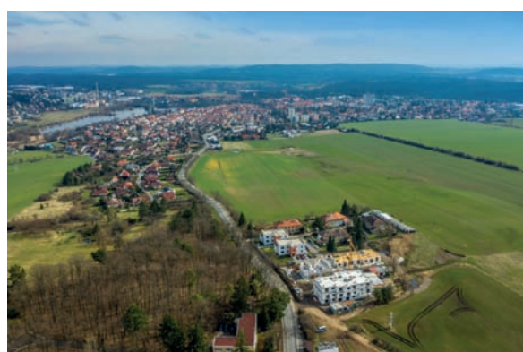
Výstavba ke dni 10. 3. 2024
